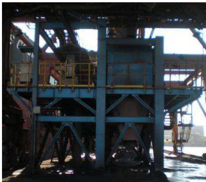
Figura 1: Vista frontal da estrutura analisada
