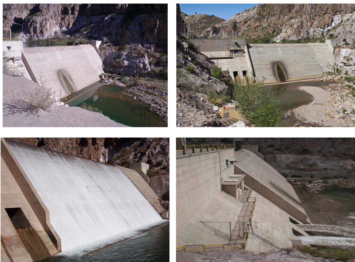
Figura 1: Presa Tierras Blancas en el sistema de presas del río Atuel.
