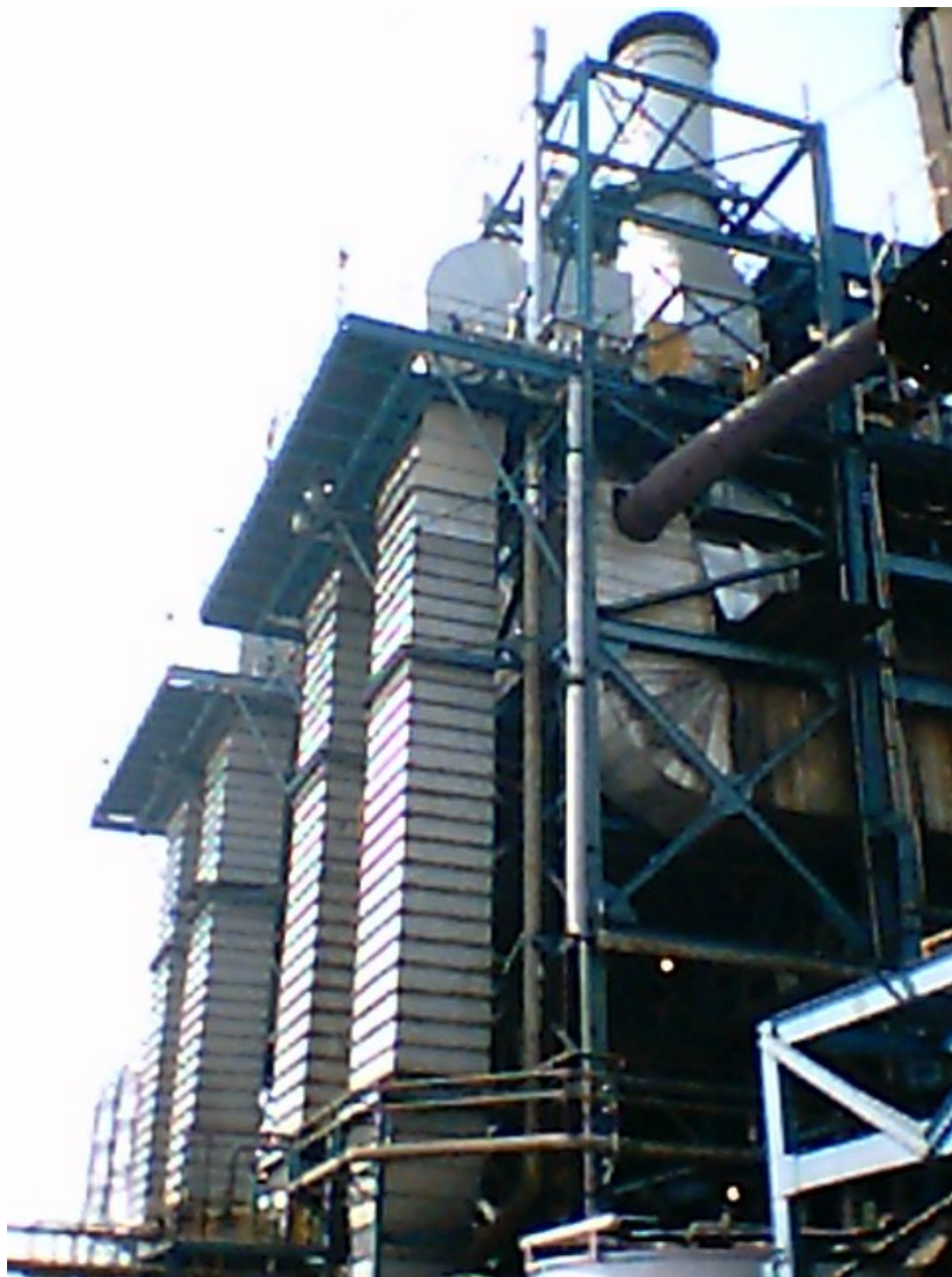
Figura 1. Esquema general del generador de vapor de 350 t/h de la planta termoeléctrica Ing. Jorge Luque.
