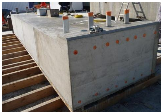
Figura 1: Vista de la viga RL1
