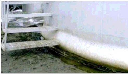
Figura 1: Falla "pata de elefante".
