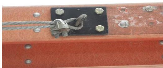
Figura 5: Detalle unión rienda – escalera
