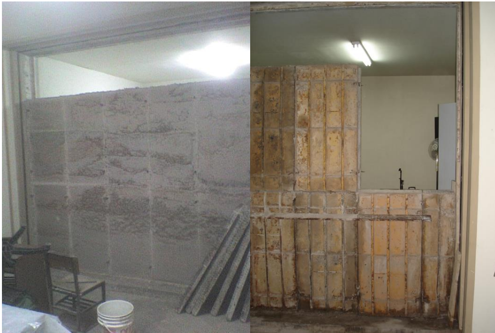
Figura 2: Vista del proceso de construcción del material bajo estudio.
