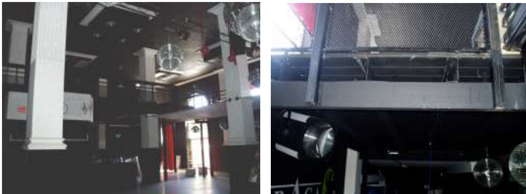
Figura 2: Entrepiso del local bailable 1 y detalle de zona metálica.
