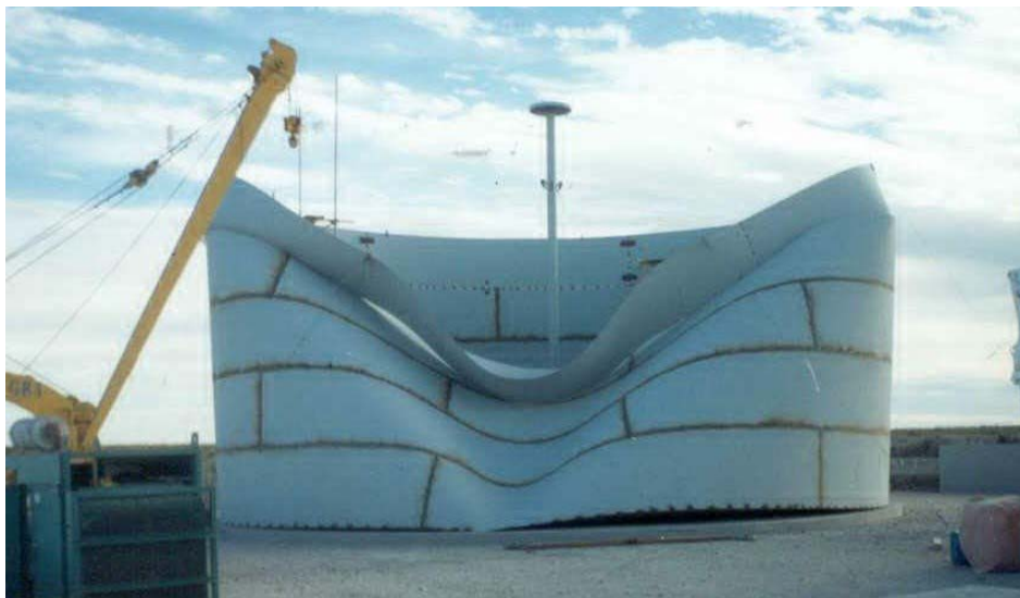
Figura 1: Estructura colapsada, en la que se aprecian las virolas y el levantamiento de parte de la soldadura entre el primer nivel y el fondo del tanque.
