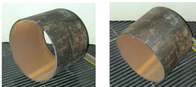
Figura 1: Fotografía de la cañería a reparar
