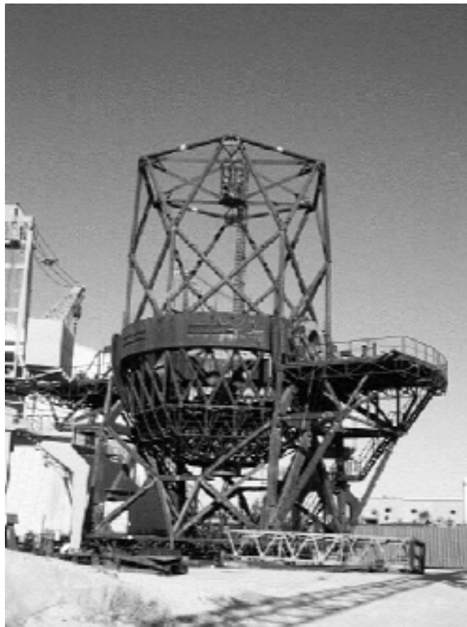
Fig. 1. Montaje de la estructura del telescopio, ubicado en las Islas Canarias.
